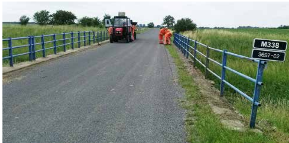
Obnovená cesta v blízkosti obce Svätúše
