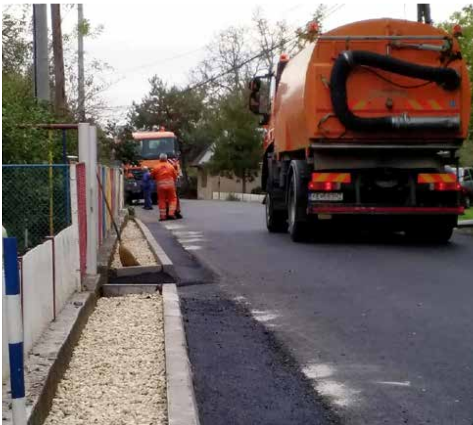
Obnova obecnej cesty v obci Rad
